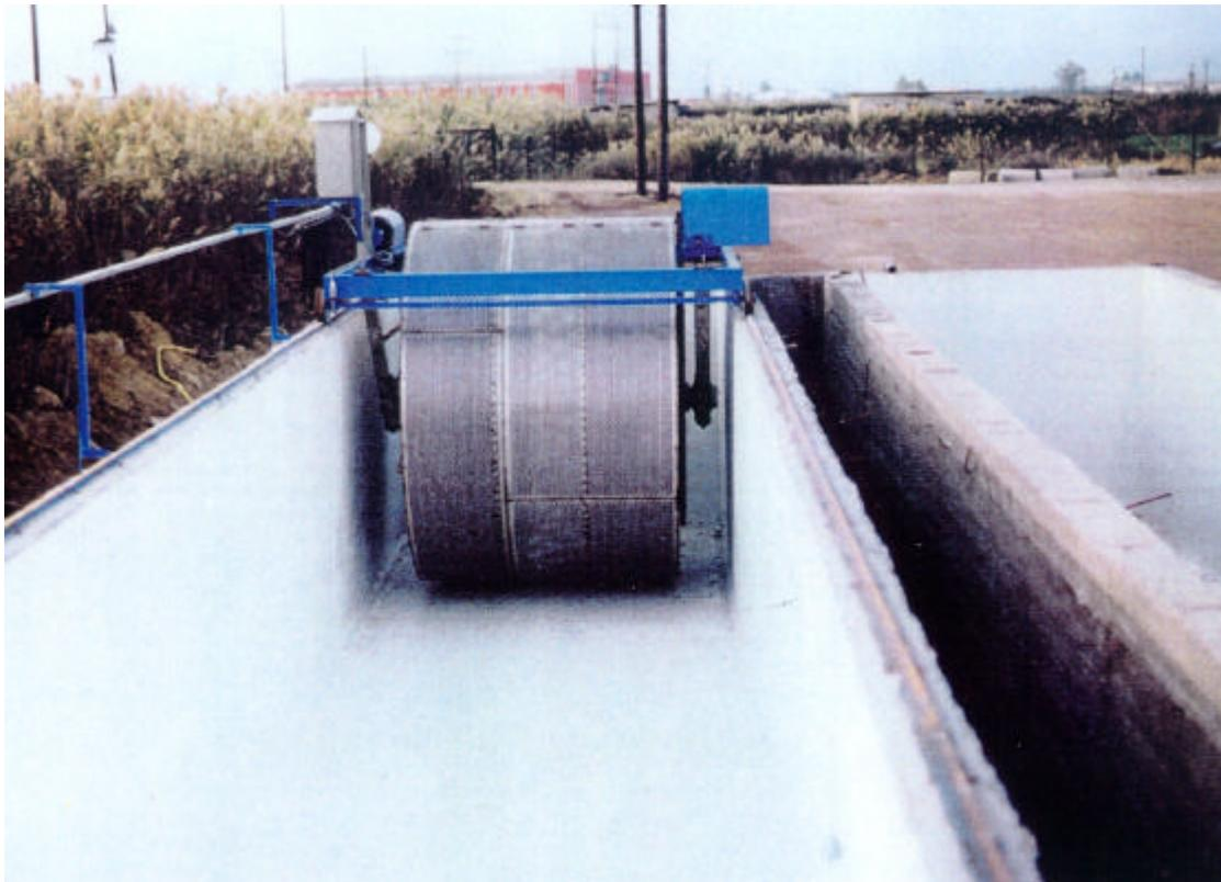
Planta en Kalamata, Grecia (Proyecto Life 1995). Velocidad de rotación 6 rpm. Velocidad lineal 1.8 m/min. Longitud del tanque 25 m. Capacidad 100 m<sup>3</sup>
