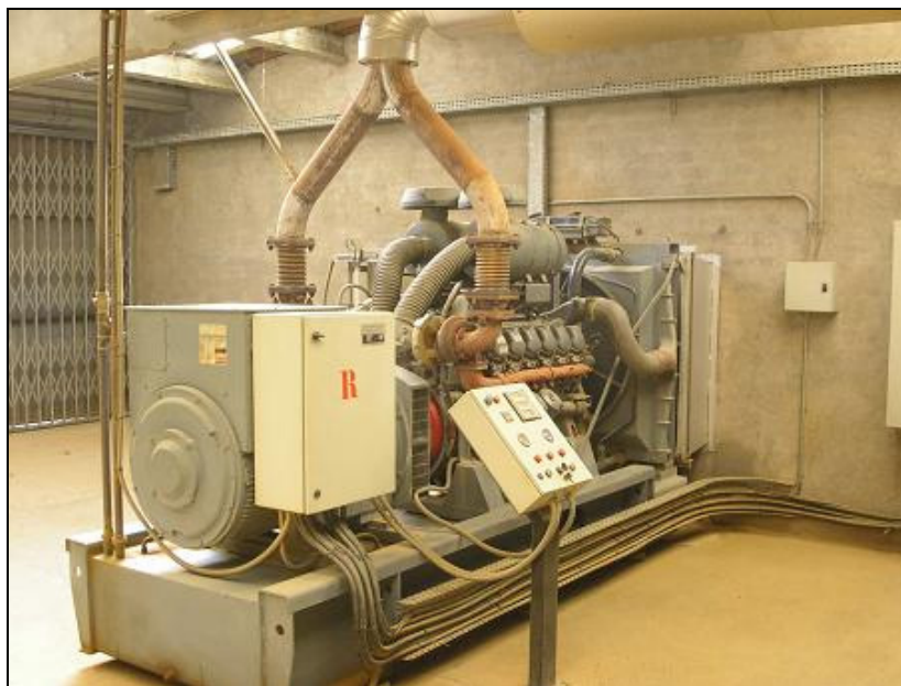
Imagen 3.13: Cogeneración que utiliza fuel como combustible
