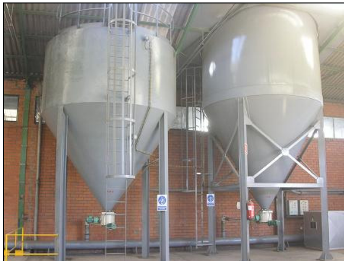
Imagen 7.2: Almacenamiento de coque de petróleo en silos
