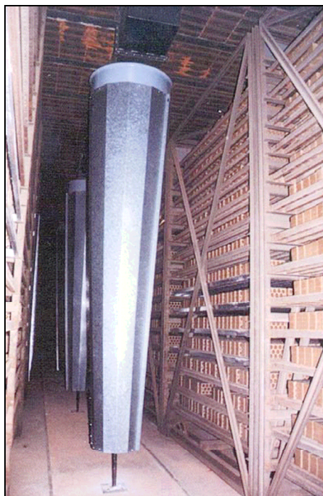
Fuente: Junta de Andalucía Imagen 6.6: Ventiladores cónicos
