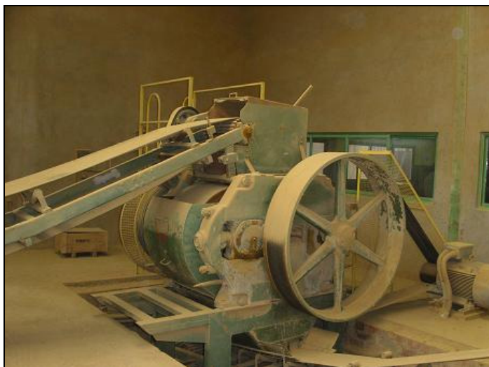
Photo 3.3 : Broyage en voie sèche
