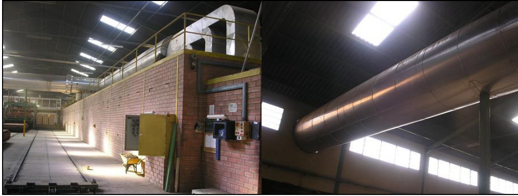
Cette photo décrit un exemple d'exploitation des gaz du four pour le séchage de la matière avant cuisson
